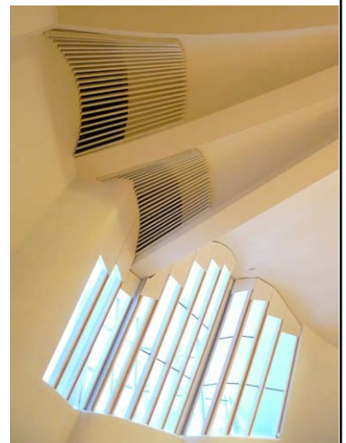
Poistoilmasäleiköt kirkkosalin katossa 2012.
