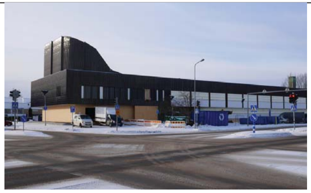
Työmaa 2018, ikkuna-aukot suojattuina
