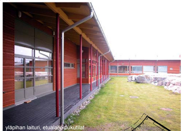
yläpihan laituri, etualalla pukutilat
