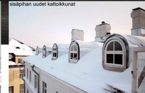
sisäpihan uudet kattoikkunat
