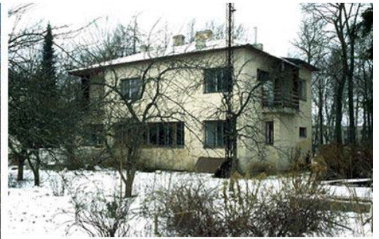
pihajulkisivu ennen restaurointia
