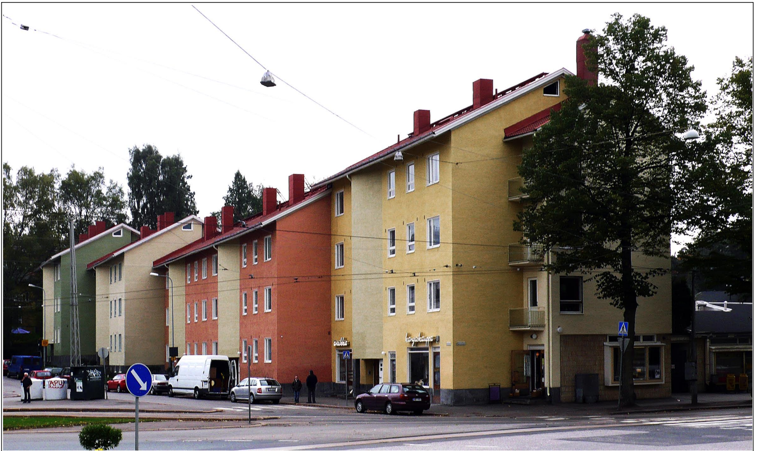
AS. OY POHJOLANKATU 43 JULKISIVUT POHJOLANKADUN JA KÄPYLÄNKUJAN SUUNTAAN JULKISIVUKUNNOSTUKSEN JÄLKEEN VUONNA 2010.
