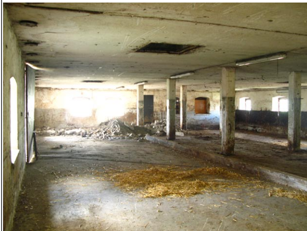
NAVETTA ENNEN MUUTOSTÖITÄ.
